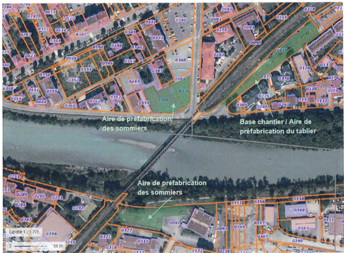
Fig.7 : Vue aérienne du viaduc sur fond de plan cadastral et base chantier (en vert) - (source : géoportail)
