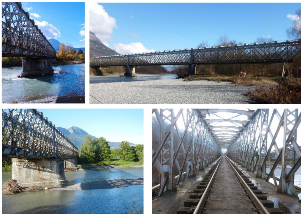
Fig. 3 : Viaduc de franchissement ferroviaire de l'Arve – état actuel
