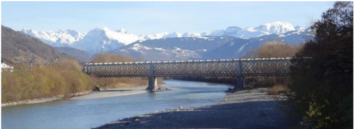
Fig. 5 : Etat actuel depuis la culée rive droite du pont de l'Europe
