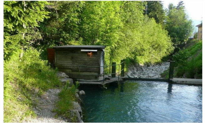
Figure 1 : Local technique au-dessus de la prise d'eau et la vanne rivière.
