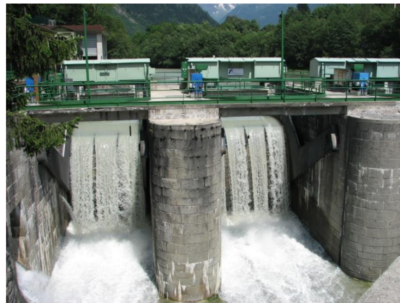
Photo 12 : Barrage EDF des Houches sur l'Arve (source : SM3A)
