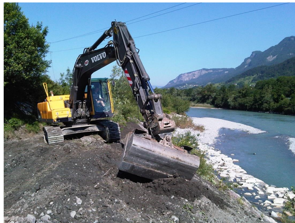
Photo 3 : Entretien des ouvrages en bord d'Arve par le SM3A
