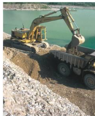
Photo 13 : Extractions industrielles sur l'Arve dans les années 1980 (source : SM3A)
