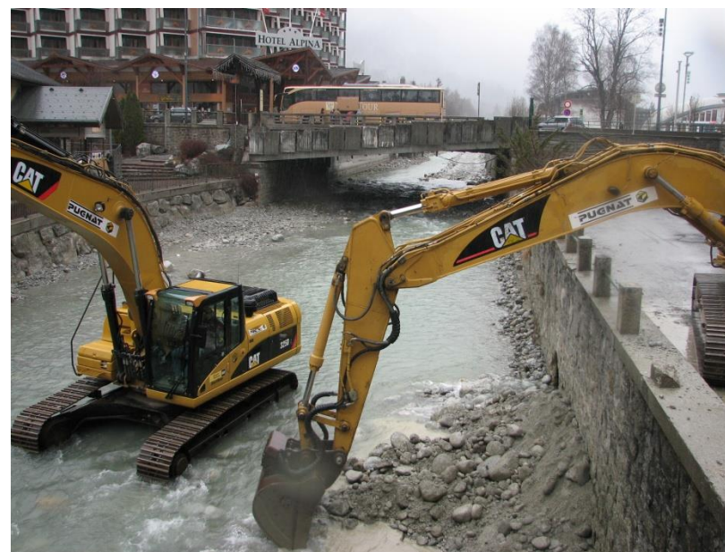
Photo 21 : Curage de sécurité par le SM3A dans la traversée de Chamonix (source : SM3A)
