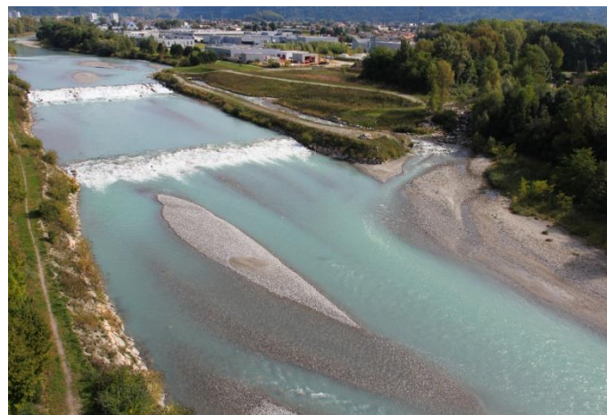
Photo 14 : Endiguements, seuils de stabilisation et rivière piscicole de contournement sur l'Arve à Pressy (commune de Thyez)
